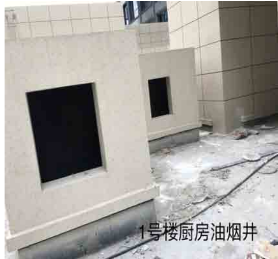
1号楼厨房油烟井
