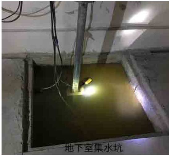
地下室集水坑
