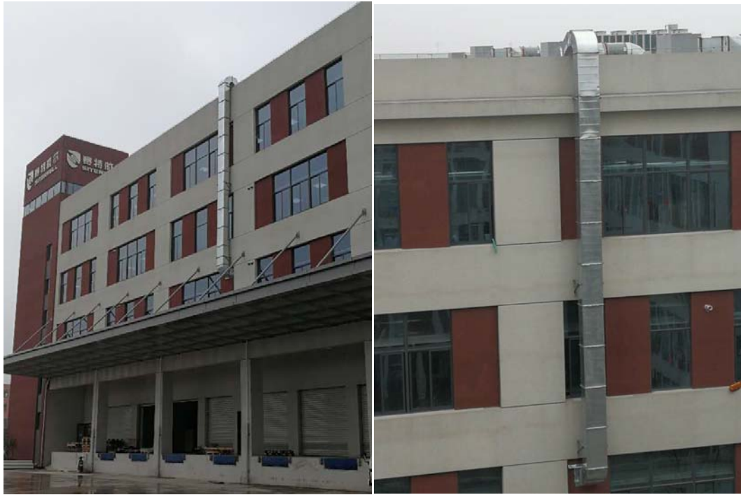
波峰焊废气排气筒焊锡流水线废气排气筒
