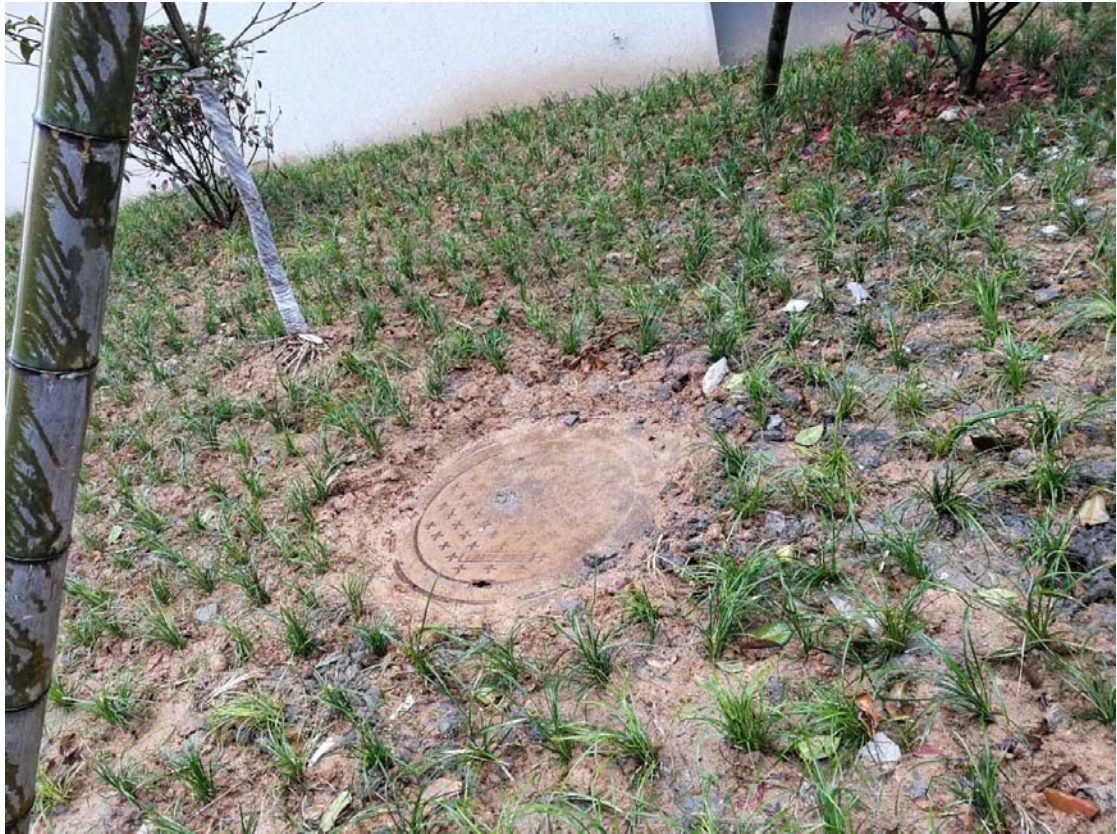
厂区内设置化粪池位置
